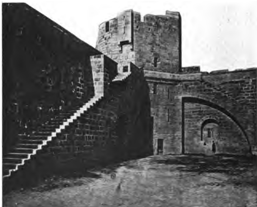
Fig. 94. — Escalier extérieur à la tour des Bourguignons. Remparts d'Aigues-Mortes.
